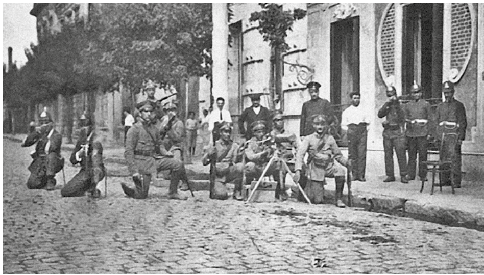
El Ejército y la Policía reprimiendo en los Talleres Vasena, Buenos Aires, 1919.
